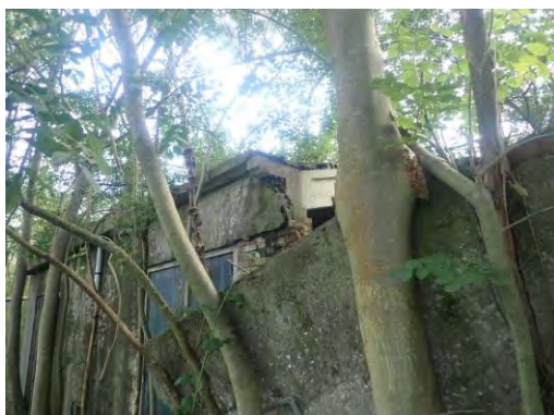
Foto 12: betonnen dakspanten steunen op een penant. Dak zelf bestaat uit bimsbeton platen.
