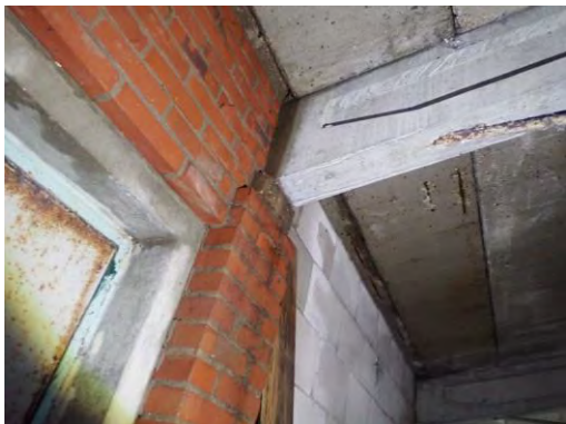
Foto 17: detail penant met oplegger van beton als ondersteuning voor dakspant. Rond de deur binnen spouwblad van metselwerk.
