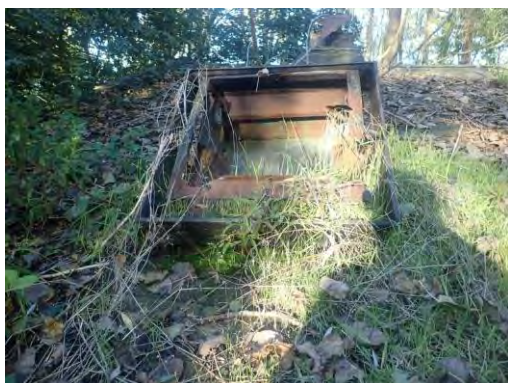
Foto 14: op alle plofhuizen een of meer ontluuchtings-/ventilatiekappen volledig van metaal gemaakt.
