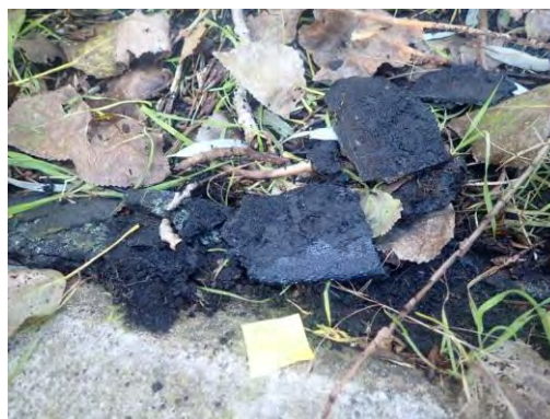
Foto 7: plofhuis B1, dakbedekking bemonsterd als M2 en als asbesthoudend beoordeeld.
