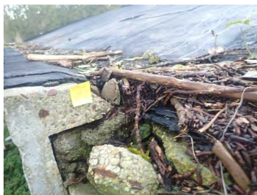
Foto 9: plofhuis A15, dakbedekking bemonsterd als M3 en als asbesthoudend beoordeeld.
