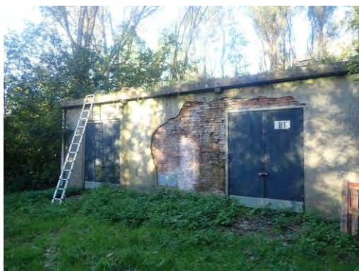
Foto 6: plofhuis B1, dakbedekking bemonsterd als M2 en als asbesthoudend beoordeeld
