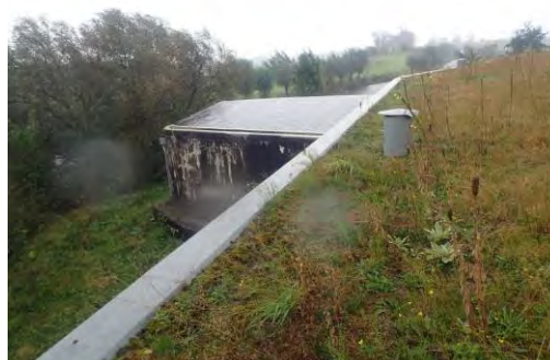
Foto 11: dak van het fort.
