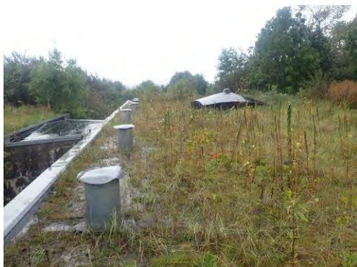
Foto 10: dak van het fort.
