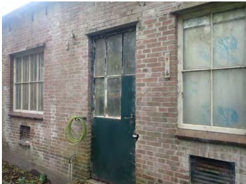
Foto 12: afgesloten achteringang welke toegang geeft tot onder meer de stookruimte.
