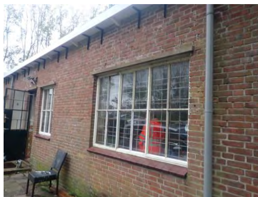
Foto 1: rondom stalen ramen met enkel glas.
