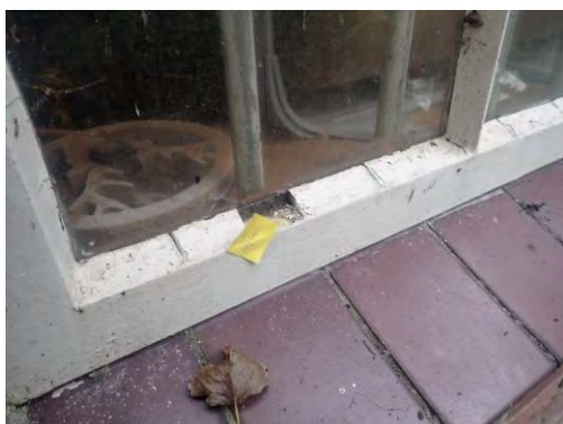
Foto 2: de kit/stopverf bemonsterd als M06 t/m M08 en alle drie de monsters als asbestvrij beoordeeld.
