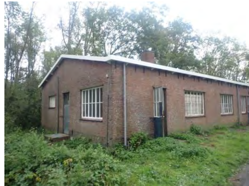
Foto 13: open deur geeft enkel toegang tot de ruimte met de meterkast. Ruimte achter raam rechts daarvan niet toegankelijk en een afgesloten zijdeur.
