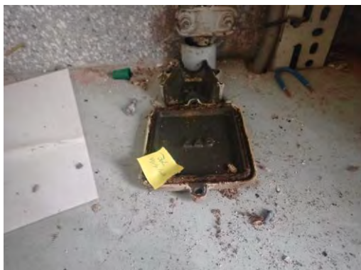
Foto 4: zie foto 3, het koord in deze eindsluiting bemonsterd als M04 en als asbestvrij beoordeeld.
