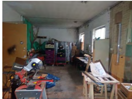
Foto 11: grote werkplaats/garage, vensterbanken zijn tegels en een betonvloer
